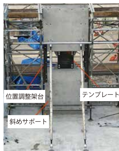
図-5 間柱固定状況
