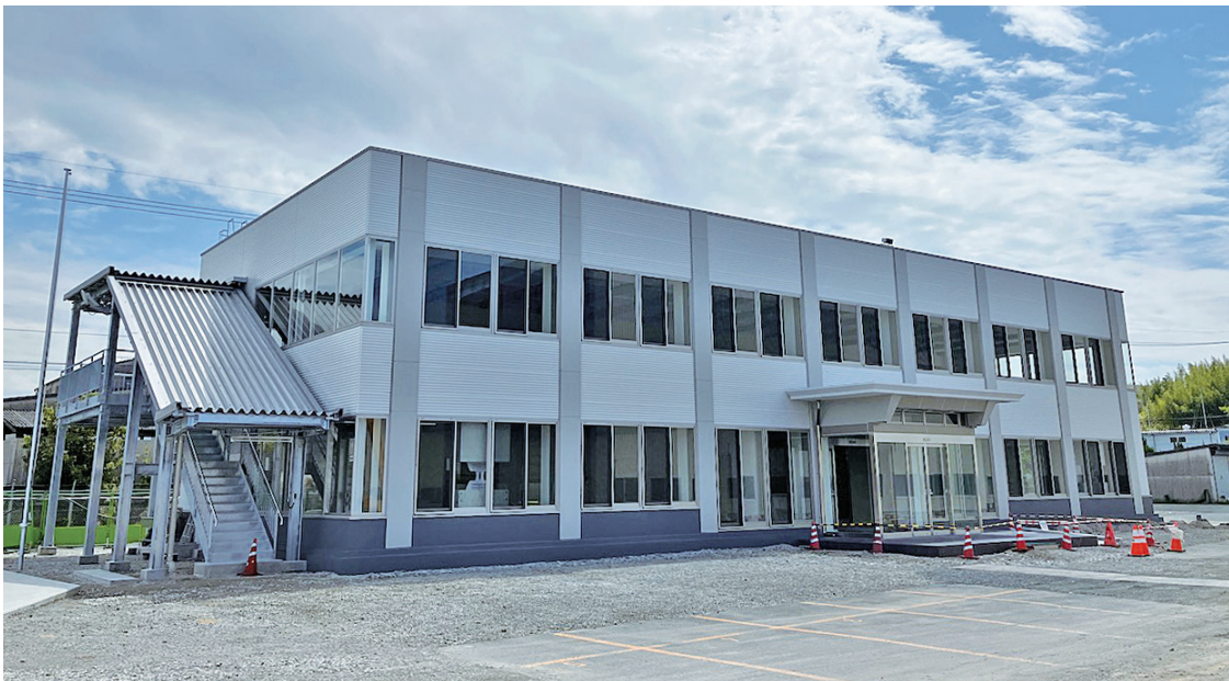
写真-1 完成写真
