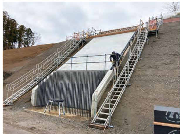
写真-4 PC版架設完了
