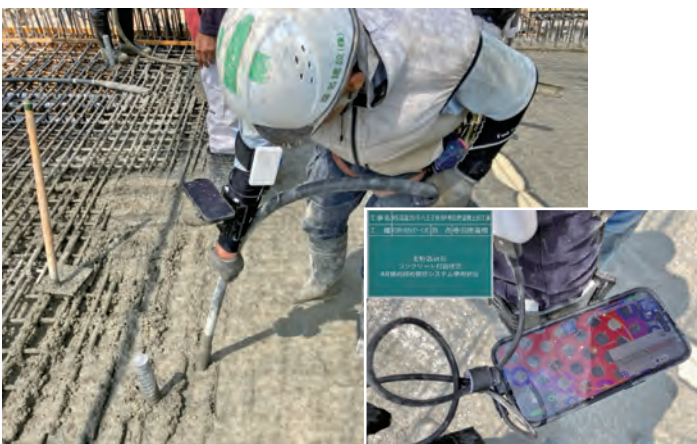
写真-5 AR締固めシステムを使用した作業状況
