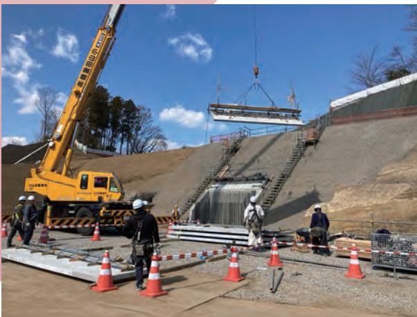
写真-3 PC版架設状況
