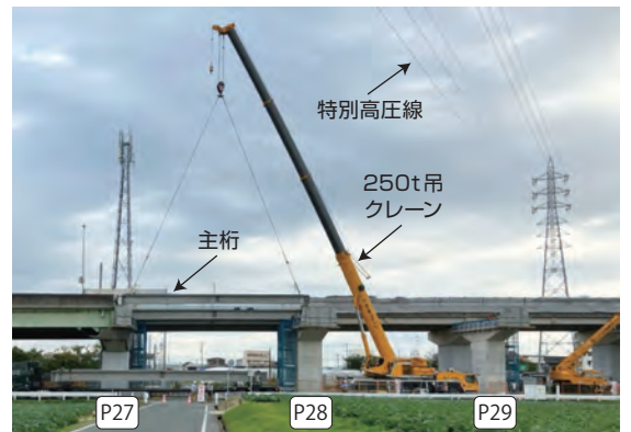
写真-2 クレーンを用いた主桁架設(P27-P28)
