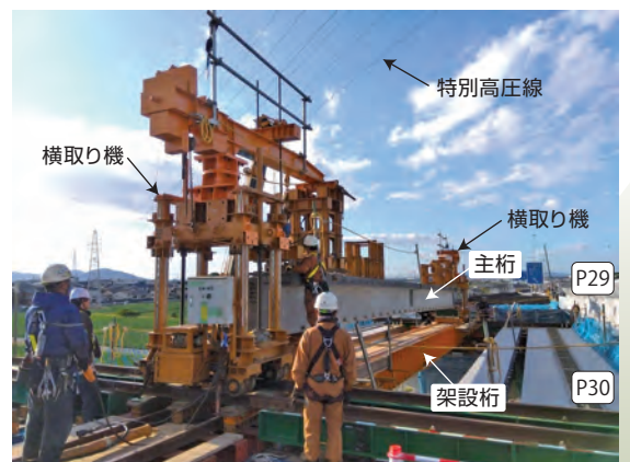
写真-3 横取り機を用いた主桁架設(P29-P30)
