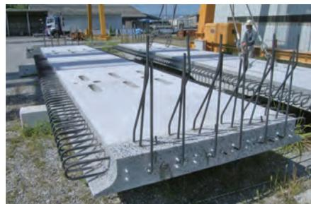
品質の保証されたJIS工場で桁を製作します。JIS桁には、「T桁」・「ホロー桁」と呼ばれる2種類の桁があります。
