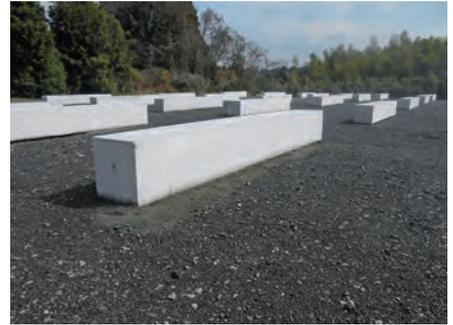
現場における型枠組立・コンクリート打設手間が不要で、所定位置にコンクリート架台基礎を配置するだけでメガソーラーシステム構築が図れます。
