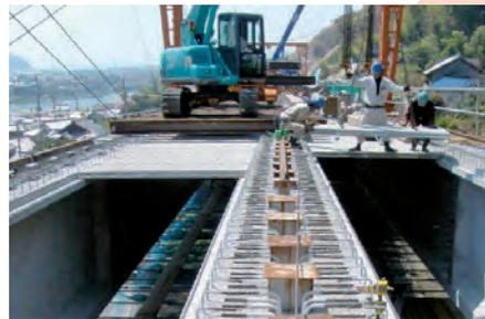
高強度コンクリート採用による高耐久性・軽量化や、工場製作による高品質化、現場作業の省力化が期待できます。
