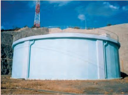
側壁を工場で製作し、現場において組み立て、円周方向にプレストレスを導入することで側壁を形成する工法です。
