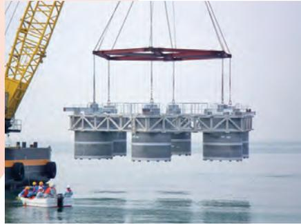
浮体は直径18m、辺長9m、高さ4mの六角形構造で、径3.5m、高さ4.0mのプレキャストPC構造の円筒6函を、プレキャストPC構造のトラス部材および連結材で接合した構造です。
