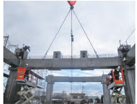
あらかじめ工場で製作されたプレキャスト部材(PCa部材)を、現場で組み立て、プレストレスにより圧着し、躯体を構築していく工法です。
