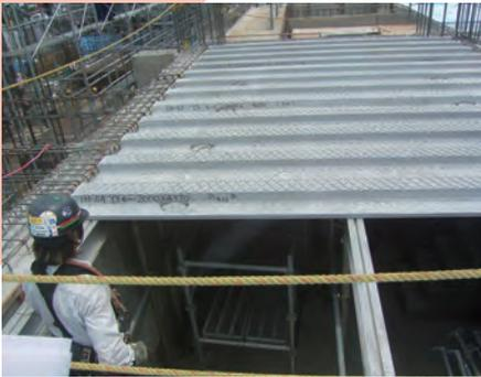
現場に敷設した後、上端筋を配置し、現場打ちコンクリートを打設して一体化するハーフPC合成床スラブ工法です。
