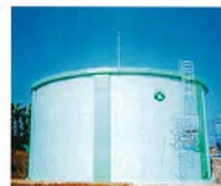
高知県浄水場中瀬川見沼東大浜村 D=16.0m H=8.1m V=1,460m 3
