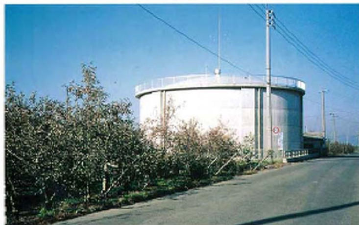
湯明地区配水池 (高野県南安藝郡三基村)
