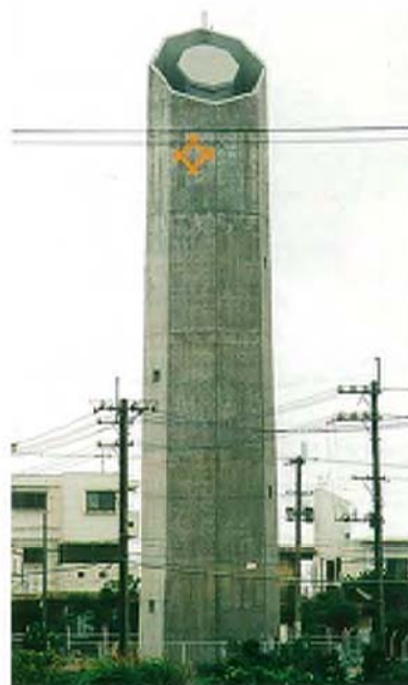
新田町高架水塔 B=5.3~5.4m H=3.0m V=50m 3
