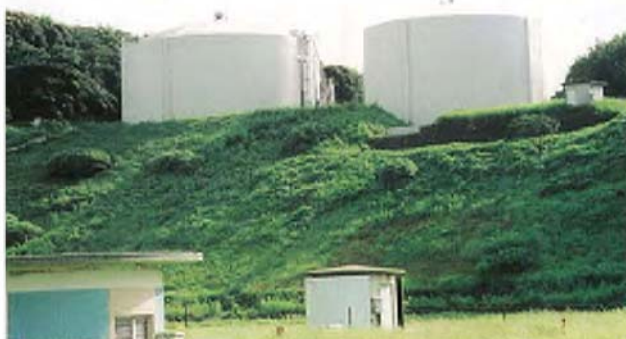
高宮浄水場高所配水池No.1 D=20.0m H=8.8m V=2,700m 3
