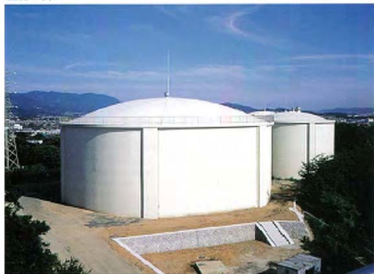
松崎4号配水池 (福岡県)
