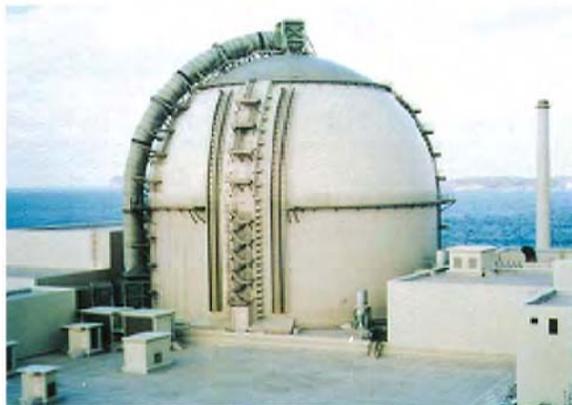
玄海原子力発電所原子炉格納容器（茨城県鹿嶋市鹿嶋町）
