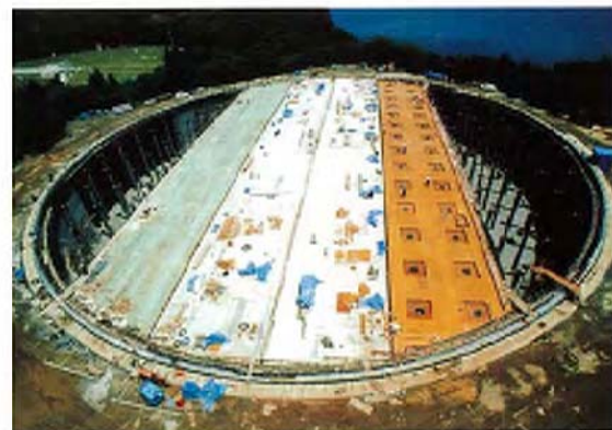
横瀬貯油所（Y-4）タンク（高知県西條市西条町） D=54.0m H=10.5m V=59,100m 3
