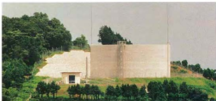
三原北部地区第2貯水池 (佐賀県小城市小町町)
