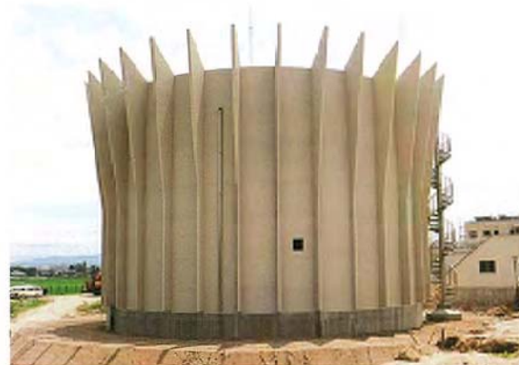
多々良浄水場 (福岡県糟屋郡粕屋町) D=18.5m H=3.0m V=800m 3
