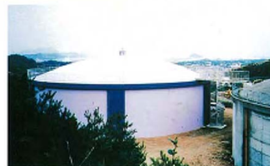
宝城配水池保通工事 (香川県三豊郡高岡町)
