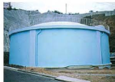
野原PCタンク (和歌山県新宮市名田町) D=20.0m H=5.2m V=1,500m 3
