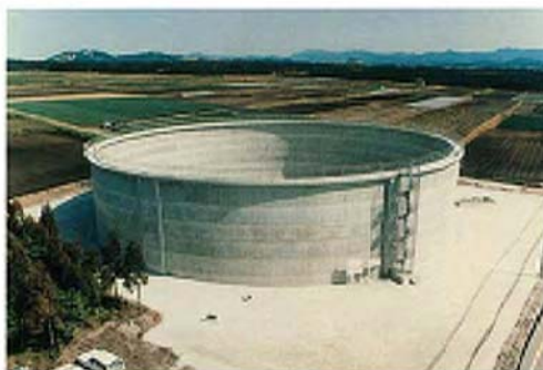
汐見原ファームポンド (鹿児島県川辺郡北郷町) D=50.0m H=10.2m V=20,000m 3
