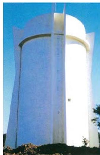
打上配水池 (佐賀県東松浦郡西郷町) D=8.0m H=5.0m V=251m 3 上層 D=8.0m H=6.5m V=326m 3 下層
