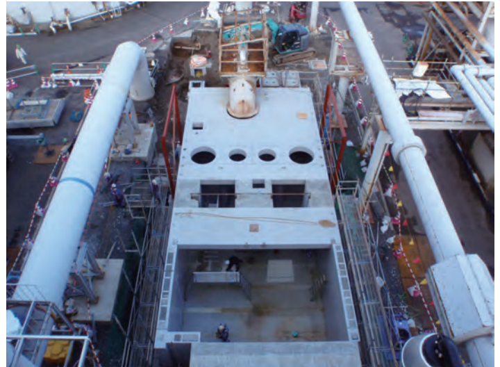
写真-1 プレキャスト水槽全景
