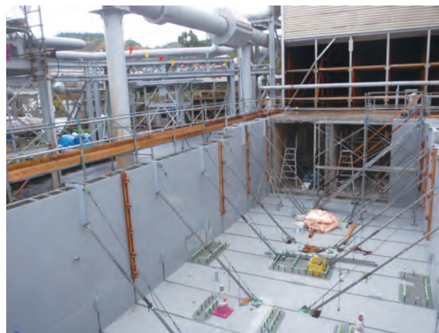
写真-3 プレキャスト部材架設状況
