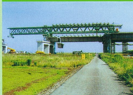
鍋田高架橋(愛知県)
