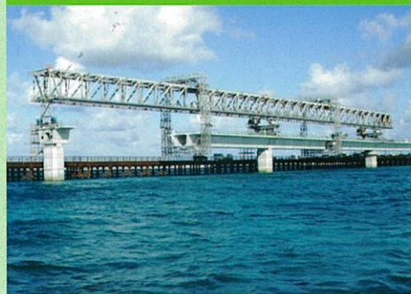
伊良部大橋(沖縄県)
