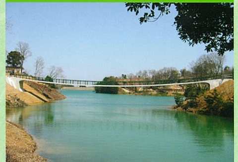
本庄池橋(福岡県)
