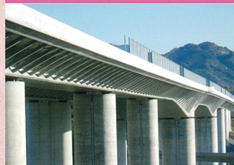
入野高架橋(静岡県)
