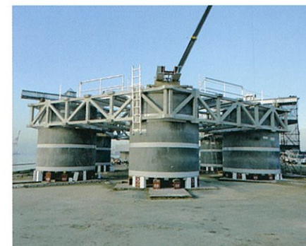
円筒浮体全景 (円筒浮体は超高強度コンクリート使用)
