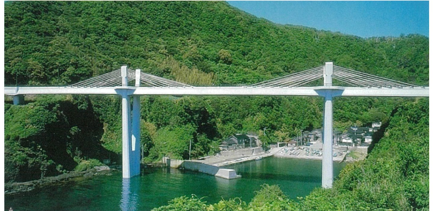
長者ヶ橋(新潟県) 橋長/294m 5径間連続エクストラードード橋 新潟県発注
