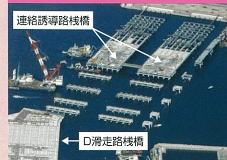
羽田D滑走路栈橋および連絡誘導路栈橋(東京都)
