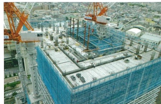
FR板敷設状況
