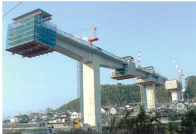
葉山大橋(熊本県) 橋長/295m PC4径間連続ラーメン箱桁橋 国土交通省 九州地方整備局発注
