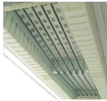
T-9荷重からA活荷重へグレードアップ(外ケーブル補強、炭素繊維シート補強)
