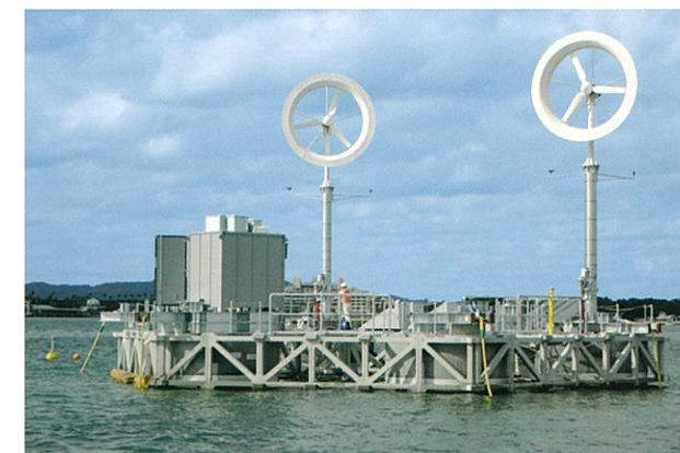
洋上風力発電施設 (PC浮体・PCTラス構造) (福岡県)
