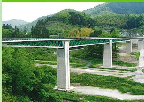
志津見大橋(島根県)
