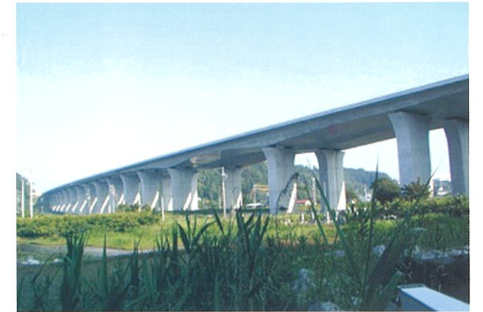
敷地高架橋(静岡県) 橋長/612m PRC(12+5)径間連続中空床版橋・PRC3径間連続箱桁橋 NEXCO中日本静岡建設局発注
