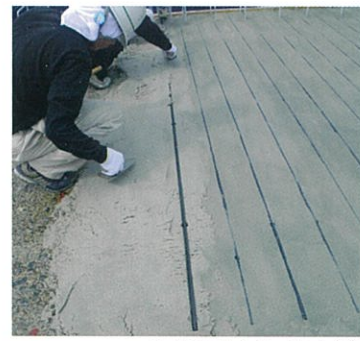
床版の拡幅と上面補強
