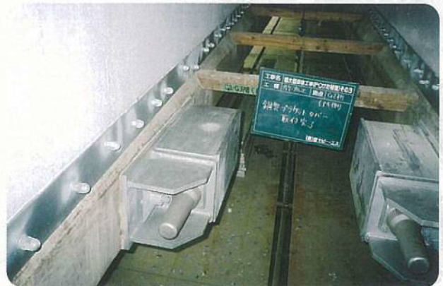
外ケーブル用定着ブラケット配置状況
