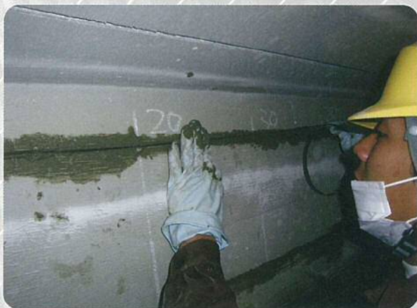
陽極材設置状況
