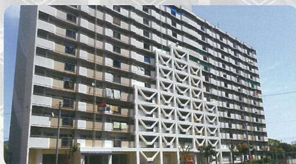
北九州市西区市営住宅(制震タイプ)
