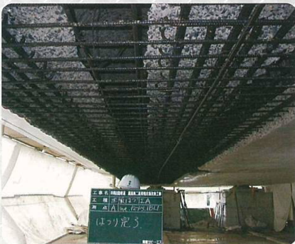
はつり完了 再配筋
