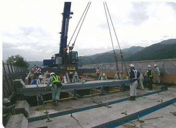
プレキャストPC床版架設
