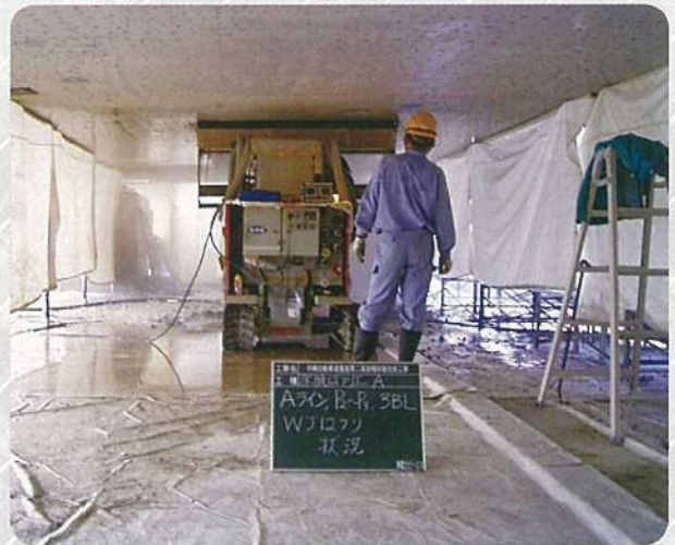
ウォータージェット工法によるはつり
