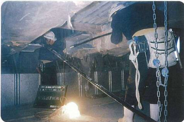
外ケーブル配置状況
