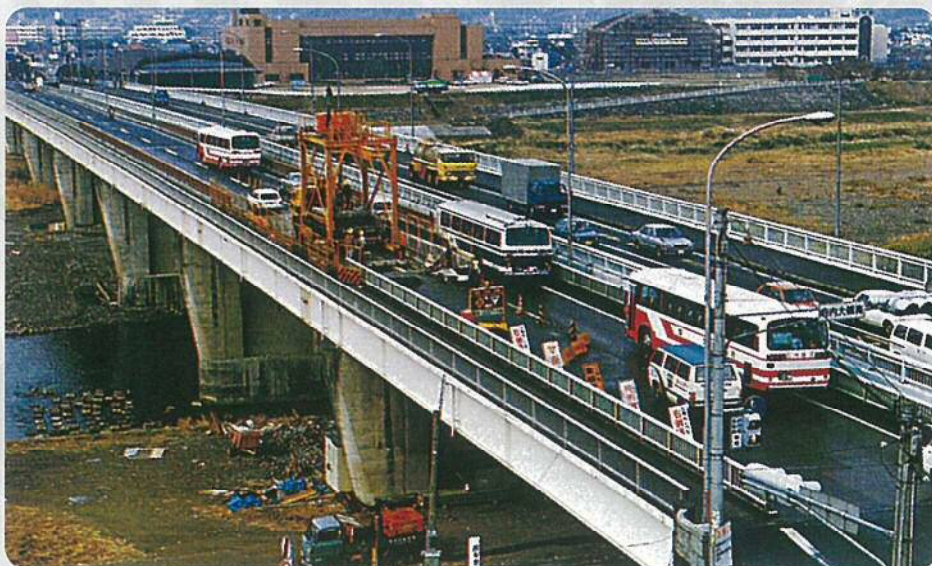
片側交通規制工事中
