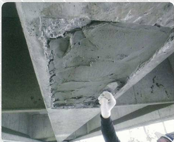
断面修復状況(橋梁)
