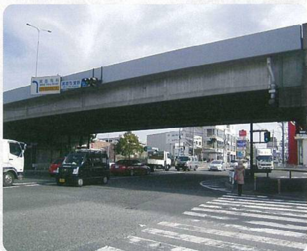
調査・補修対象構造物の立地状況
