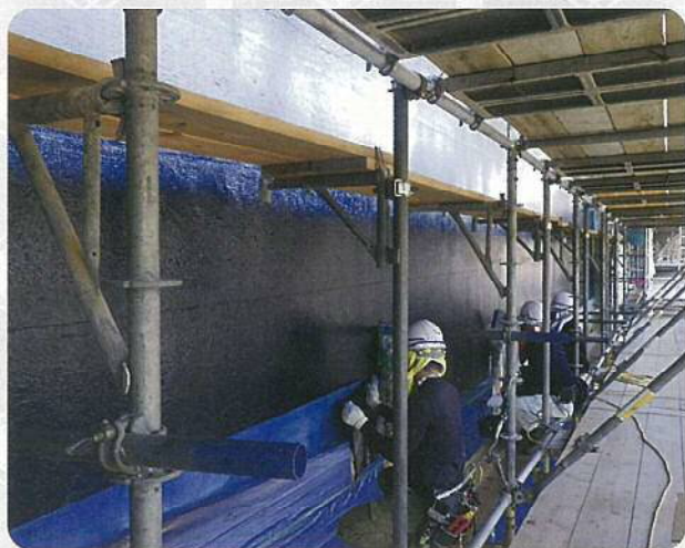
炭素繊維シートの設置状況(主桁ウェブ)
