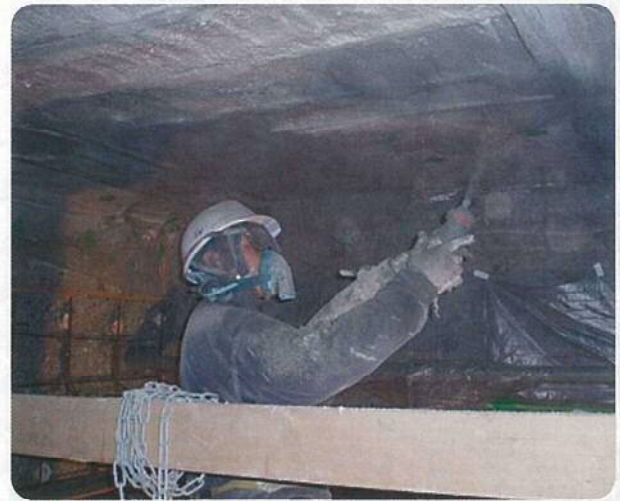
断面修復(湿式吹付工法)
