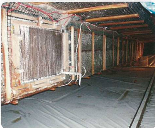
脱塩(通電)状況
