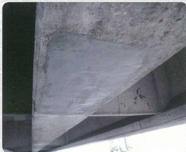
断面修復完了(橋梁)
