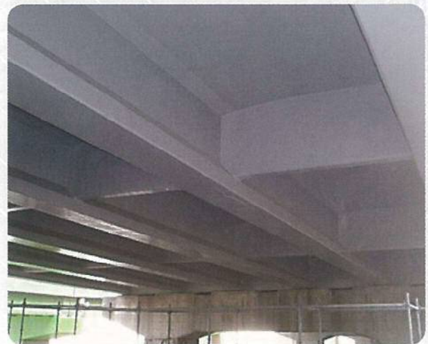
脱塩後仮設材撤去し表面保護塗装完了
