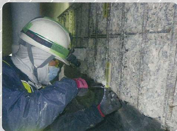
陽極材設置状況
