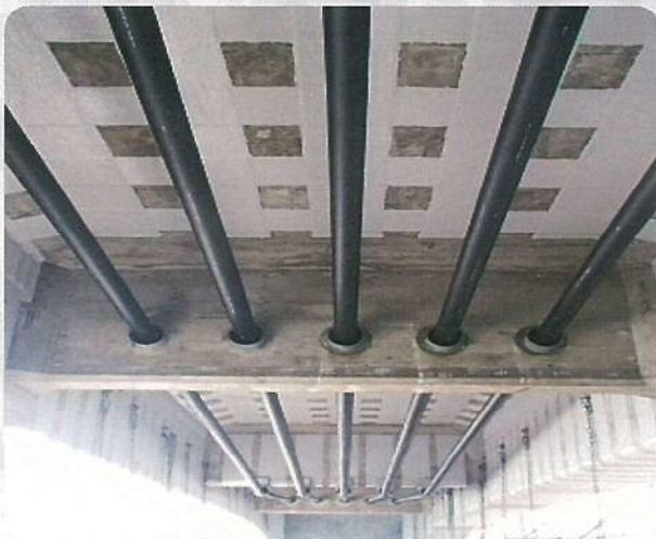
外ケーブルの設置
