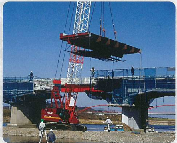
鋼桁架設
