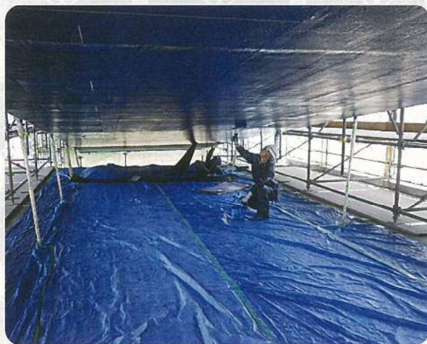
炭素繊維シートの設置状況(主桁下床版)
