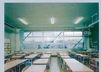
補強完了(内部)
