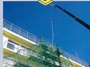
斜ケーブル挿入
