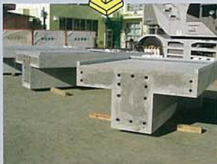
PCa柱部材搬入
