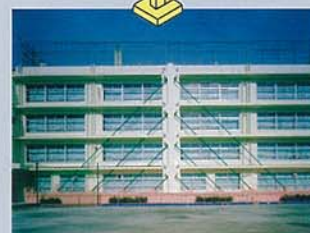
補強完了(全景)
