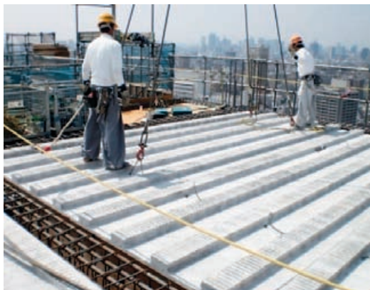
FR板敷設状況
