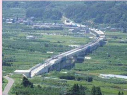
複合3径間連続ラーメン箱桁橋 小滝川橋（広島県呉市） 国土交通省 中国地方整備局
