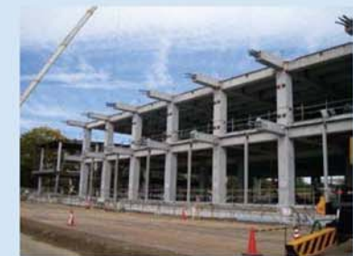
PcaPc工法 アステラス製薬㈱ 第5号館（施工中） （茨城県つくば市）
