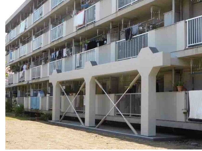
①神奈川県 ②集合住宅 ③スラブタイプ2構面 ④あと施工アンカー接合
