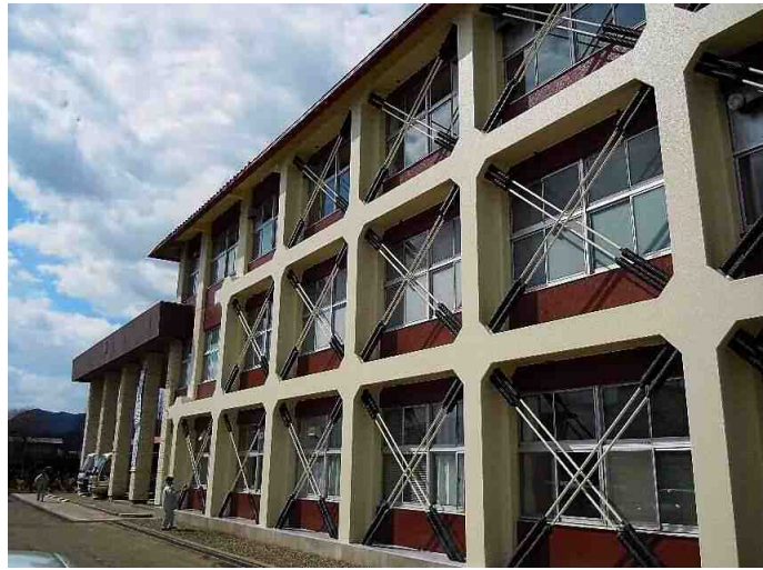
①秋田県 ②学校 ③直付タイプ45構面 ④圧着接合
