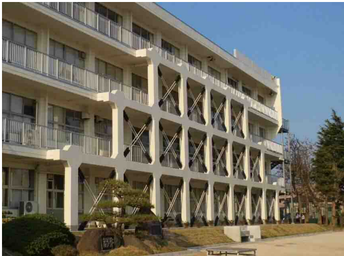
①茨城県 ②学校 ③スラブタイプ47構面 ④圧着接合
