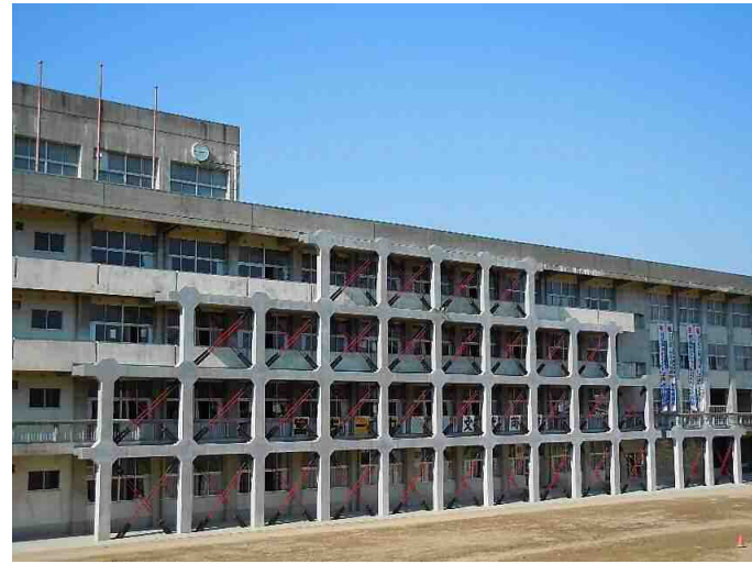
①岩手県 ②学校 ③スラブタイプ67構面 ④圧着接合
