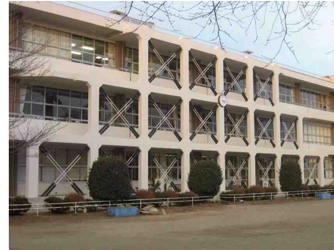
①栃木県 ②学校 ③スラブタイプ22構面 ④圧着接合
