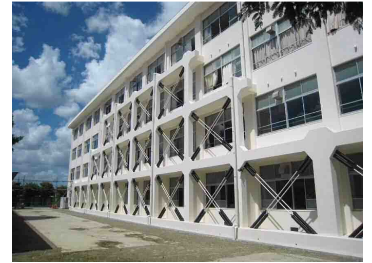
①奈良県 ②学校 ③直付タイプ20構面 ④圧着接合
