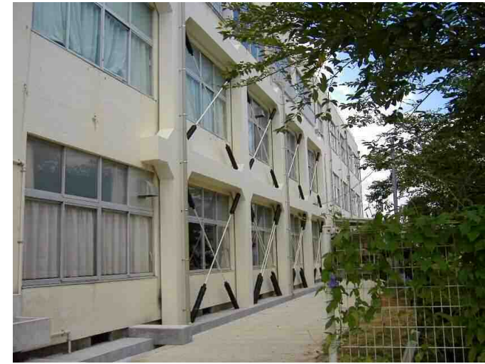
①長崎県 ②学校 ③直付タイプ9構面 ④圧着接合
