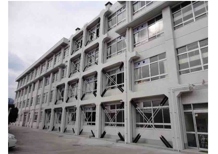
①広島県 ②学校 ③直付タイプ37構面 ④圧着接合
