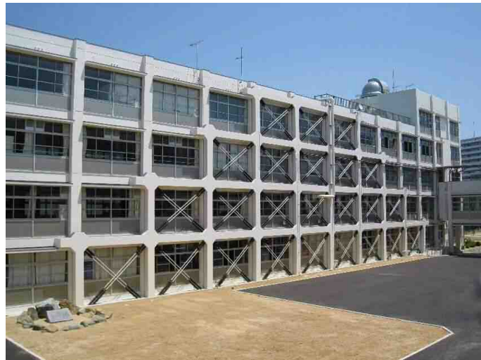
①兵庫県 ②学校 ③直付タイプ34構面 ④圧着接合
