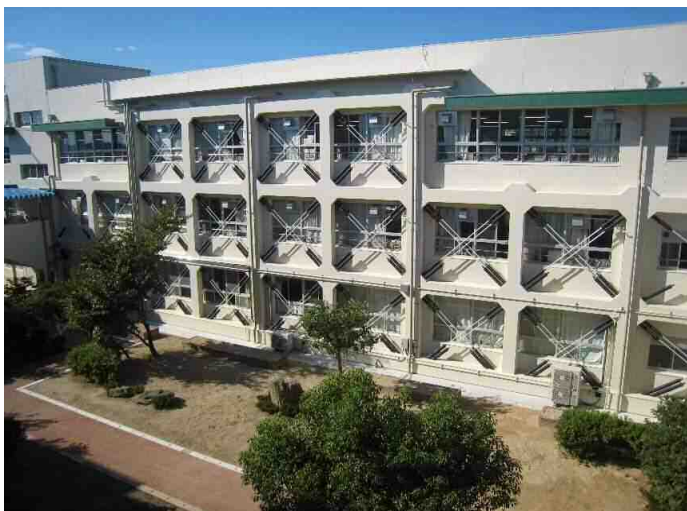
①大阪府 ②学校 ③直付タイプ22構面 ④圧着接合
