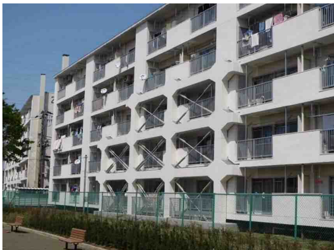
①神奈川県 ②集合住宅 ③PCaスラブタイプ28構面 ④鋼管コッター接合
