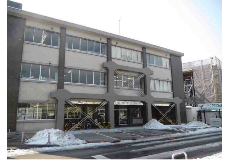
①栃木県 ②庁舎 ③直付タイプ5構面 ④鋼管コッター接合
