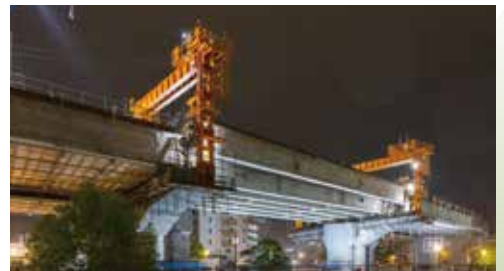
写真-10 門構設備によるPC桁の架設状況
