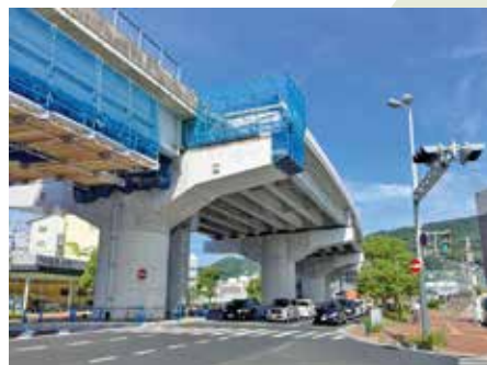
写真-3 下部工・上部工拡幅完了外観
