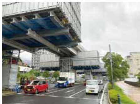
写真-1 下部工拡幅施工外観
