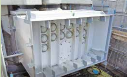
写真-4 橋脚鋼製梁の接合(1BL目)
