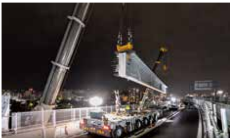
写真-8 PC桁の本線上への吊上げ
