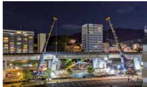
写真-7 大型クレーンによるPC桁の相吊り架設
