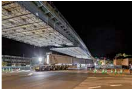
写真-6 自走多軸台車によるPC桁の運搬(県道上)
