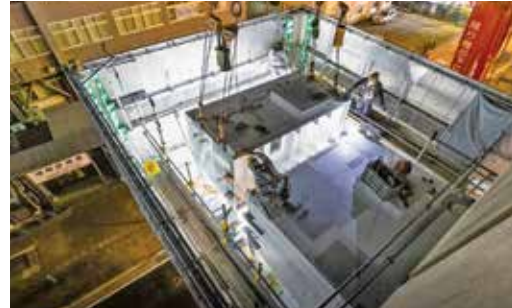
写真-5 橋脚鋼製梁の接合状況(2BL目)
