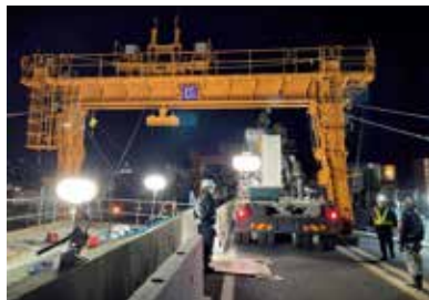
写真-9 門構設備の設置
