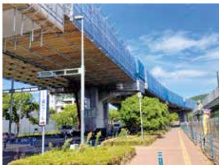
写真-2 上部工拡幅施工外観
