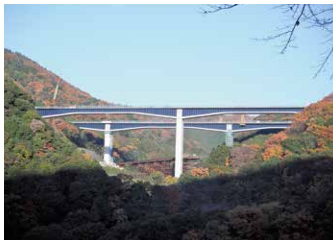
写真-1 波形鋼板ウェブPC橋 下音羽川橋
