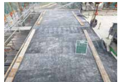
写真-2 コンクリート養生状況
