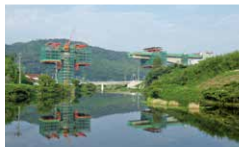
写真-3 張出施工状況
