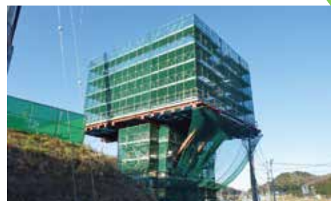
写真-2 柱頭部施工状況
