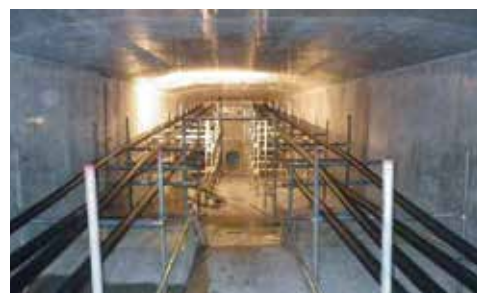
写真-5 外ケーブル工完了
