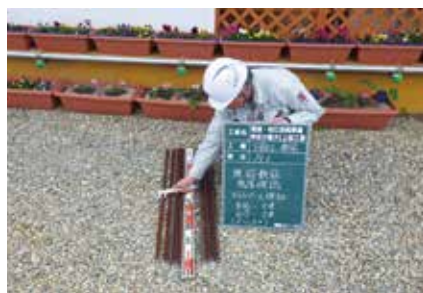
写真-7 鉄筋の強度確認
