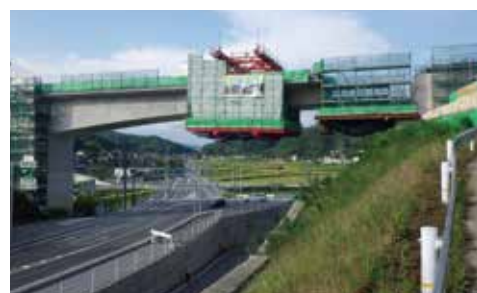
写真-4 A1側径間部施工状況
