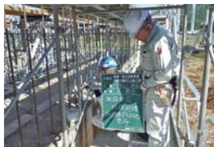
写真-6 鉄筋防錆処理状況
