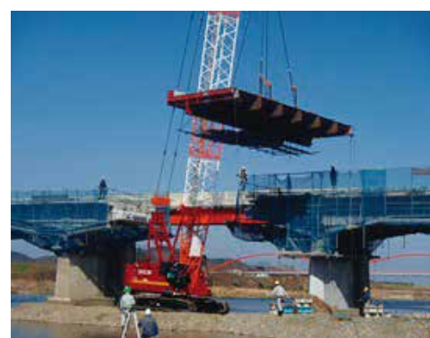
写真-4 鋼橋架設状況
