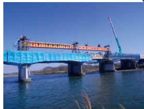
写真-2 架設桁による吊桁の撤去状況
