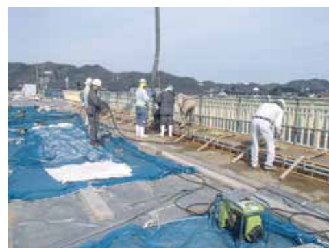
写真-5 橋面施工中
