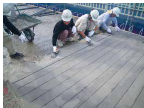
写真-3 樹脂モルタルおよびCFRPロッドの施工
