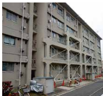
写真-4 施工事例-1
