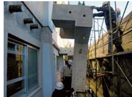
写真-3 PCa部材の架設状況
