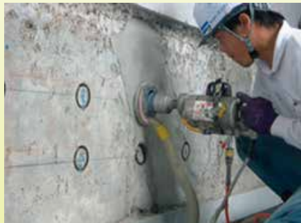
写真-1 削孔状況
