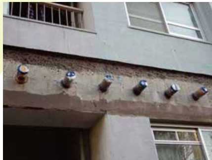
写真-2 鋼管コッター取り付け状況
