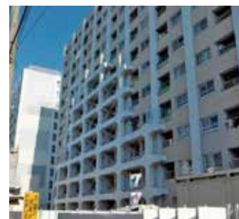
写真-5 施工事例-2
