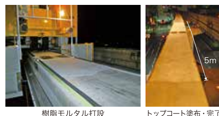
写真-4 軌道桁の嵩上げ状態
