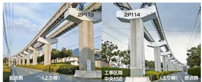
写真-1 施工区間・全景
