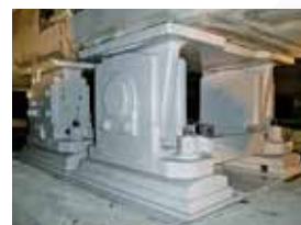
写真-8 塗装工・完了
