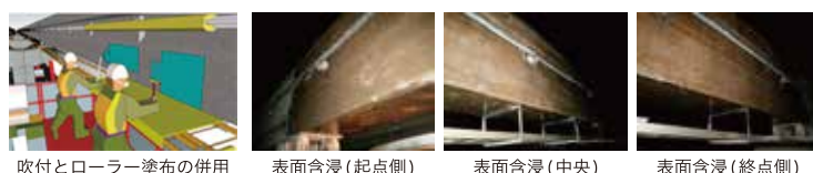
図-4 含浸材塗布方法
