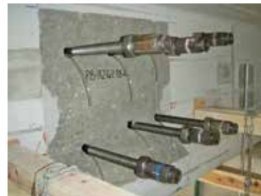
写真-3 中空PC鋼棒配置状況
