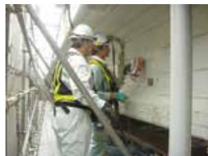
写真-1 RCレーダ探査状況
