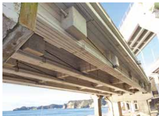
写真-6 工事完了
