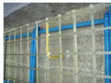
写真-5 ガラス繊維グリッド配置状況
