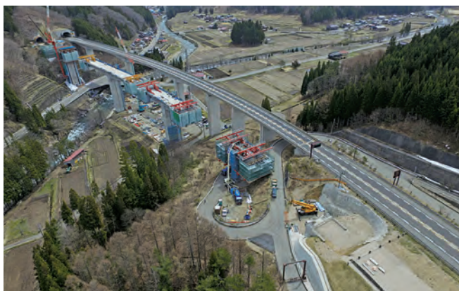
写真-3 惣則橋施工状況
