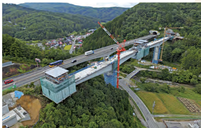
写真-4 黒谷橋施工状況
