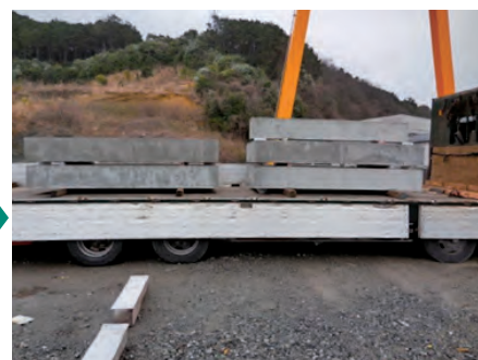
⑥ 搬出（製品の積み込み）
