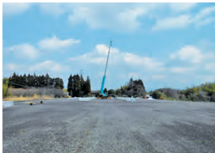
⑦ 現場・クレーンによる製品の荷卸しと設置
