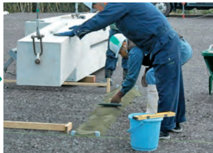
⑧ 基礎据付け箇所の不陸調整
