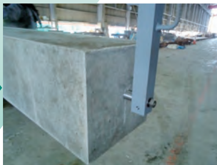
② コンクリート打設・脱枠後 製品吊り上げ方法
