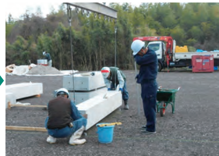
⑨ 基礎の据付け
