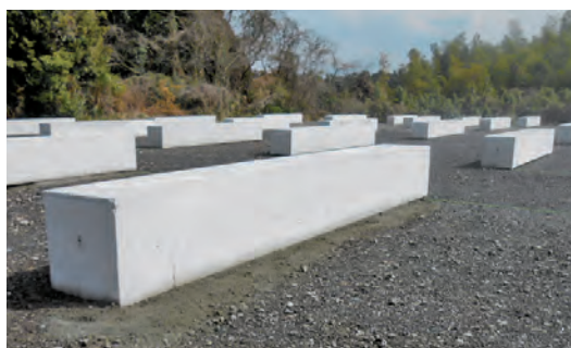
⑩ 基礎の据付け完了
