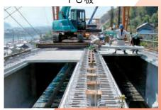
PCコンポ橋の床版施工時はPC板を敷 設し、型枠・足場とするため、吊り足場や 支保工等の設置・解体が不要となります。
