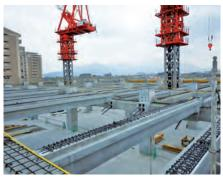
あらかじめ工場で製作されたプレキャス ト部材(PCa部材)を、現場で組み立て、 プレストレスにより圧着し、躯体を構築 していく工法です。
