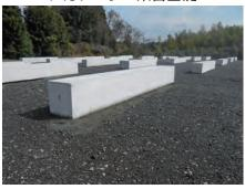
現場における型枠組立・コンクリート打 設手間が不要で、所定位置にコンクリー ト架台基礎を配置するだけでメガソー ラーシステム構築が図れます。
