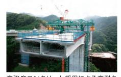
高強度コンクリート採用による高耐久 性・軽量化や、工場製作による高品質化、 現場作業の省力化が期待できます。
