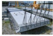
プレキャスト床版は、車の走行方向に対 して直角の方向を、プレテンション方式 によるPC構造としており、ひび割れを 許さない耐久性に優れた床版です。
