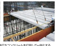
現場に敷設した後、上端筋を配置し、現場打ちコンクリートを打設して一体化する ハーフPC合成床スラブ工法です。
