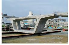
桁を工場や現場付近で製作し、架橋位置 にて輪切りの桁をプレストレスにより接 合して1本の橋桁とする工法です。
