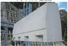
あらかじめ工場で製作された壁高欄を 架橋地点まで運搬し、現場で組み立て、 接合する工法です。
