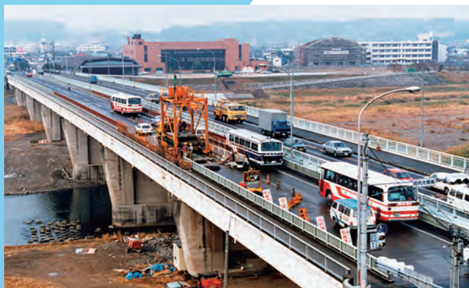
床版取替 (昭和60～61年)
