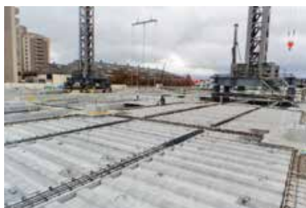
FR板の架設
