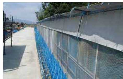
写真-5 橋面飛散・落下物防止対策
