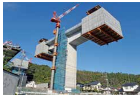
写真-4 防音シート・タワークレーン
