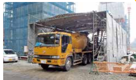
写真-3 防音ゲージの設置
