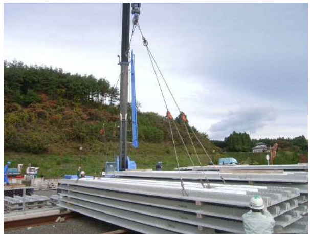
吊り状況写真
