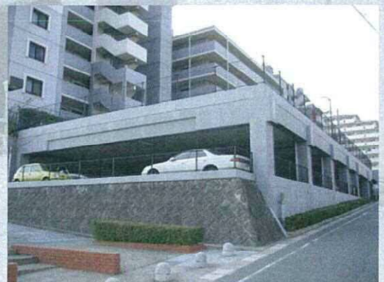
西鉄月の浦マンションA棟駐車場 設計 司建築設計事務所 施工 不動建設
