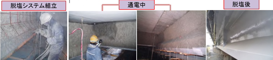
チタンメッシュを棧木・プラスチックアンカーで固定 ファイバー吹き付け状況 電解質溶液散布状況 ファイバー保持状況 表面被覆塗装状況
